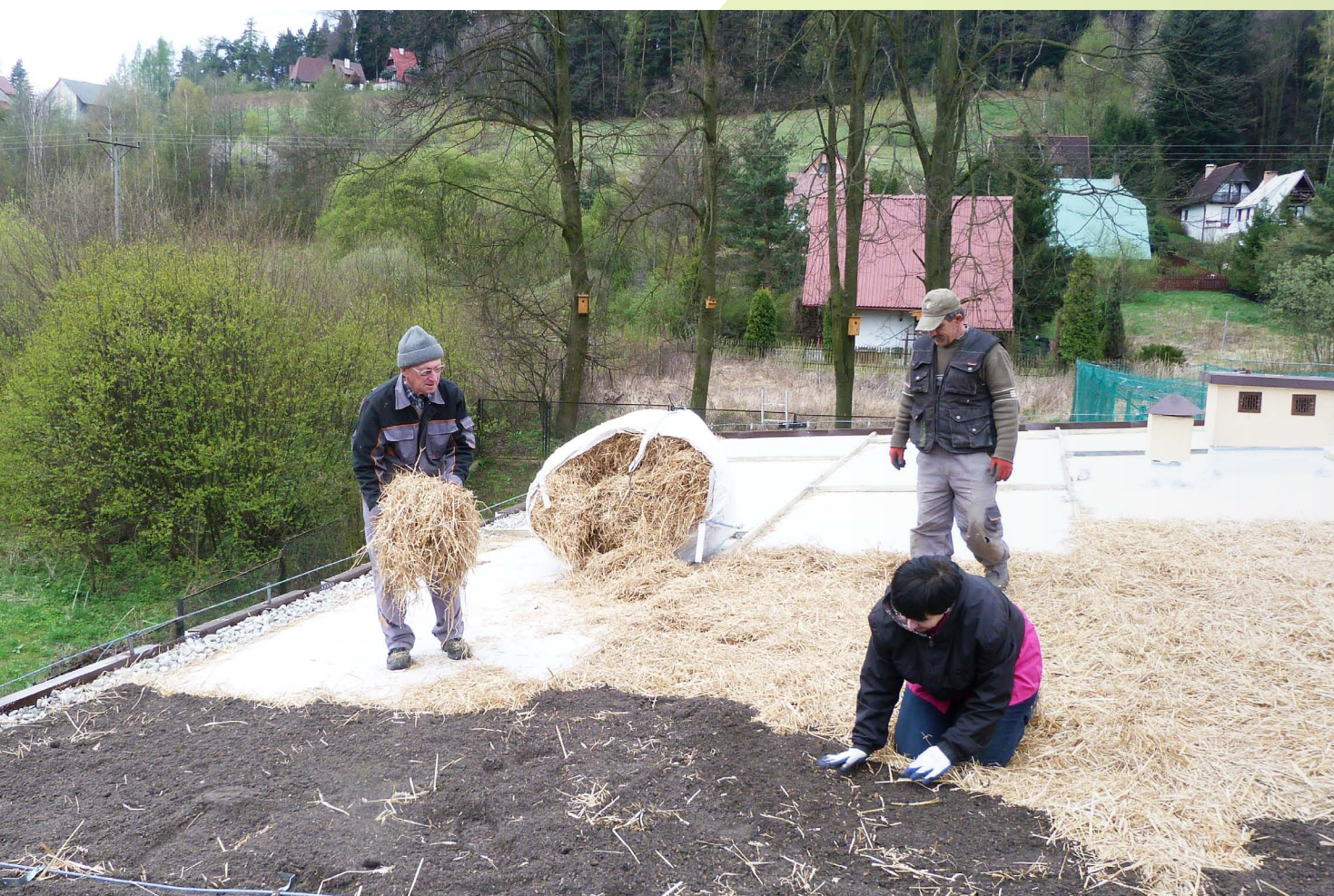
Układanie warstw – słomy, substratu i odwodnienia z pospółki. Foto: Jan Papież
