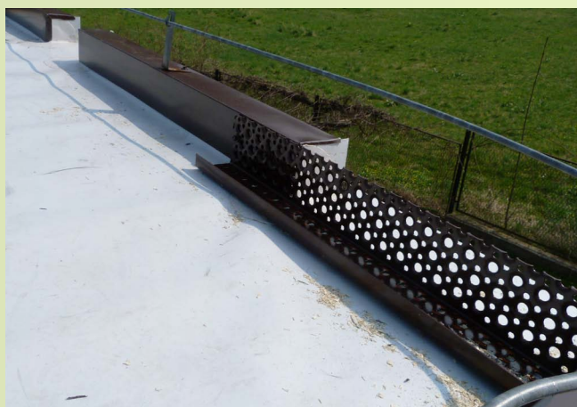
Na zdjęciu widać założoną membranę firmy Bauder. Hydroizolację dachu wraz z naszą spółką wykonała firma EUROBAU. Foto: Jan Papież
