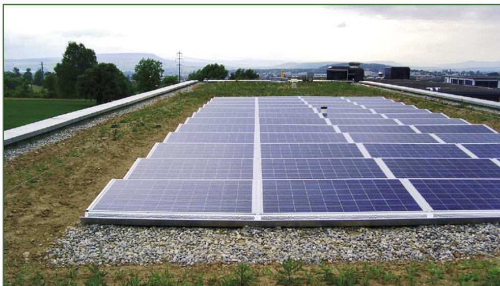
Fot. 16. Nowo zainstalowany dach wraz z panelami słonecznymi, Zurych [autor: M. Mioduszewska].
