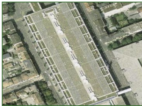
Fot. 48. Widok całości dachu Hali Wystawowej w Bazylei [autor: Geoportal Kanton Basel-Stadt].
