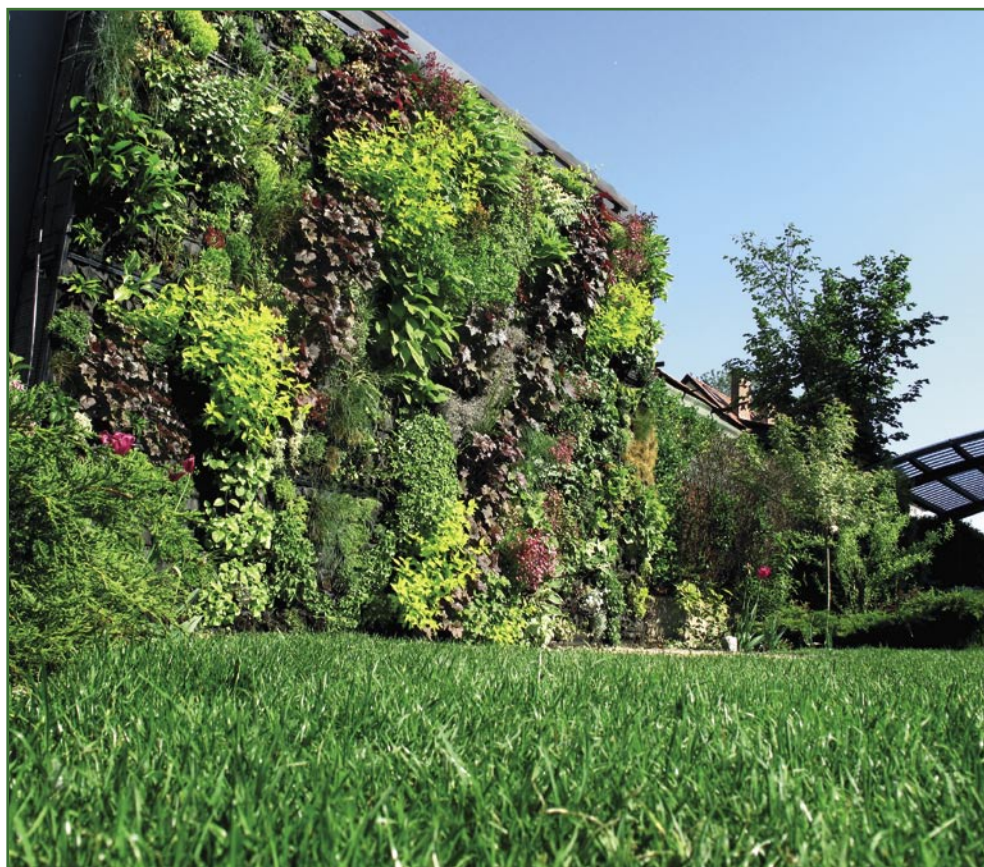
Fot. 13. Modułowa zewnętrzna żyjąca ściana mocowana na wolnostojącej konstrukcji nośnej [autor: D. Skarżyński].
