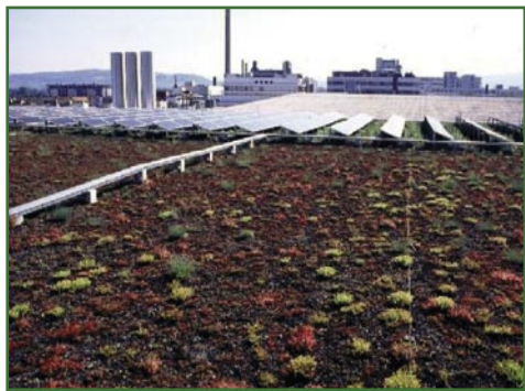
Fot. 47. Widok roślinności dachowej, Hala Wystawowa w Bazylei [autor: S. Brenneisen].
