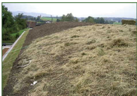
Fot. 42. Widok gotowego dachu po zakończeniu instalacji [autor: S. Brenneisen].
