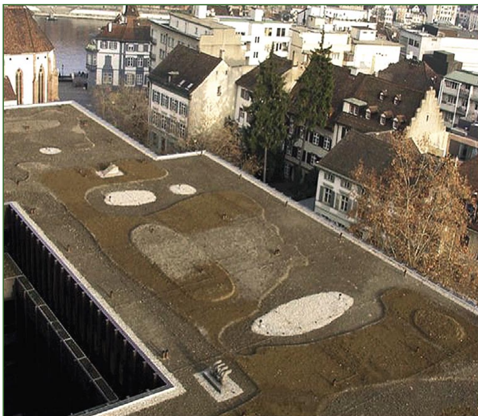
Fot. 36. Instalacja widoczna z lotu ptaka [autor: S. Brenneisen].
