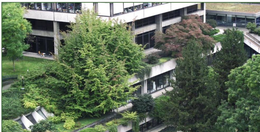
Fot. 20. Dach zielony w Bazylei [autor: A. Jaskuła].
