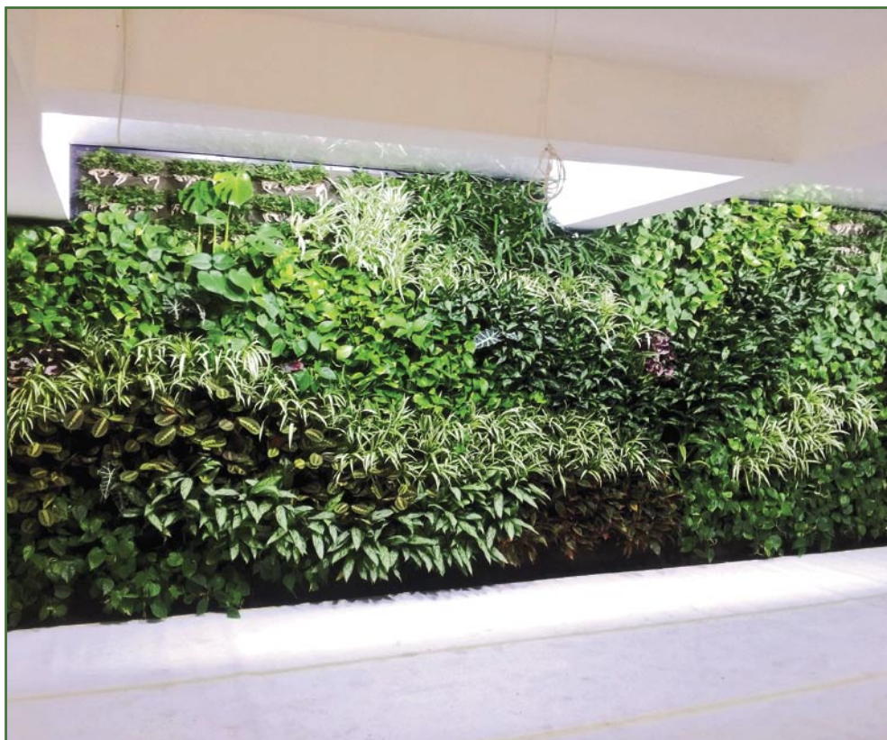
Fot. 11. Zielona ściana we wnętrzu ze specjalistycznym oświetleniem [autor: D. Skarżyński].
