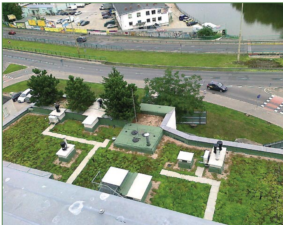
Fot. 28. Fragment zagospodarowania dachu na wieżowcu Odra House we Wrocławiu [autor: M. Weber-Siwirska].
