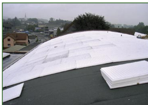
Fot. 43. Widok dachu kopulastego podczas instalacji [autor: S. Brenneisen].
