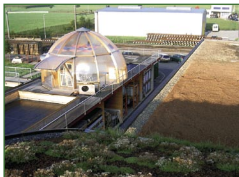
Fot. 45. Widok dachu z terenem rekreacyjnym po zakończeniu instalacji [autor: S. Brenneisen].
