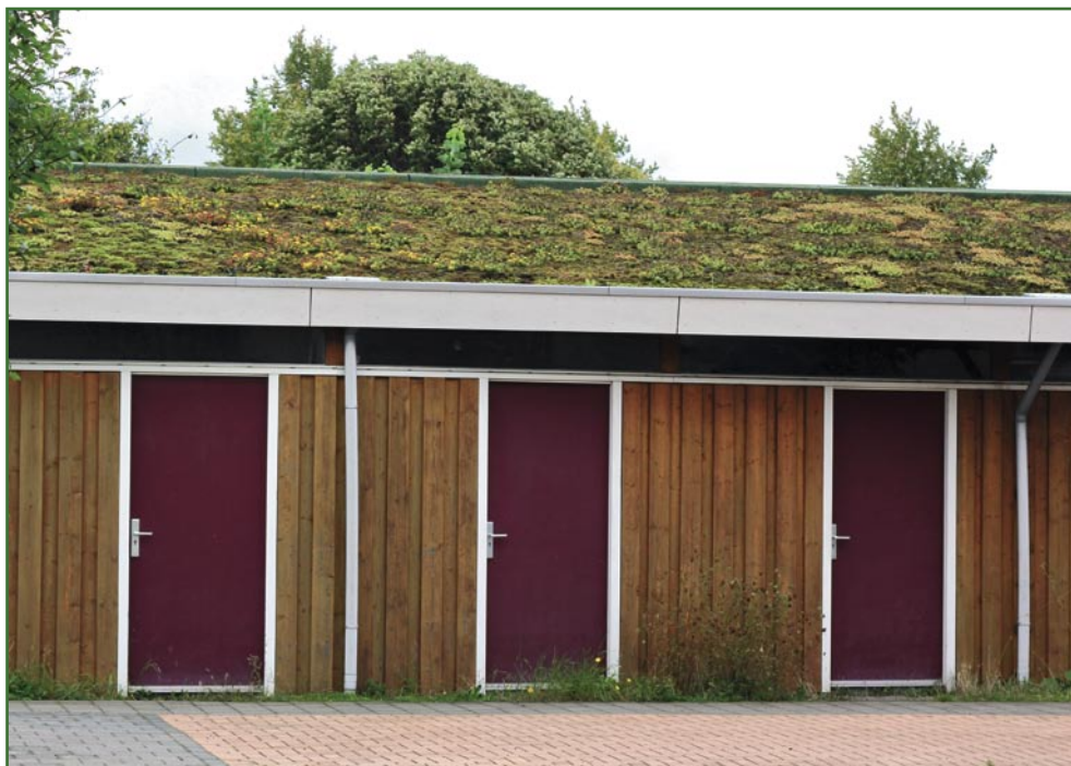
Fot. 8. Dach ekstensywny w ekologicznej wiosce – Holandia [autor: E. Walter].
