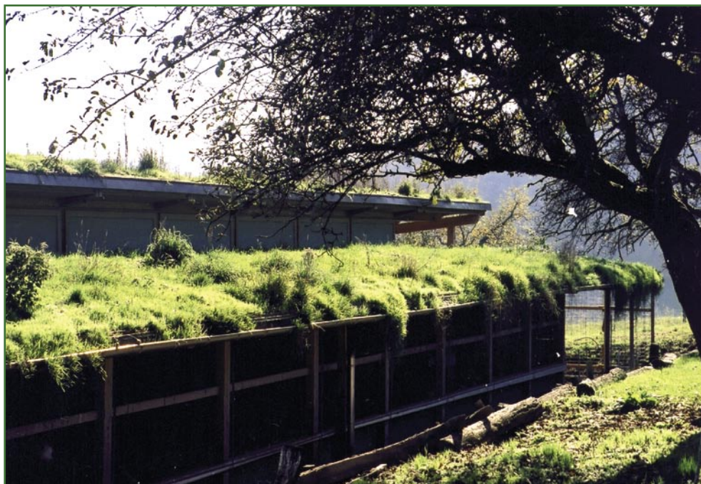
Fot. 35. Dach zielony fermi organicznej, widok z tyłu budynku [autor: P. Zanetti].
