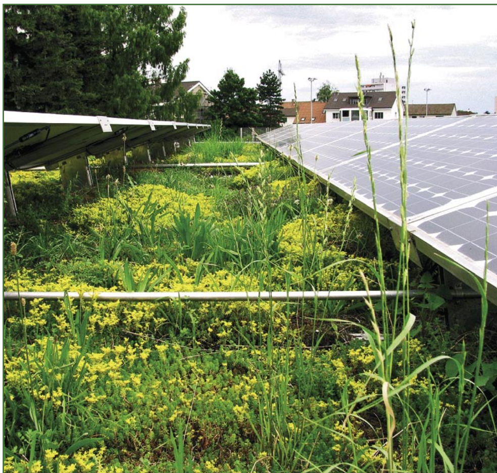
Fot. 23. Dach zielony z panelami słonecznymi, Bazylea [autor: M. Mioduszewska].
