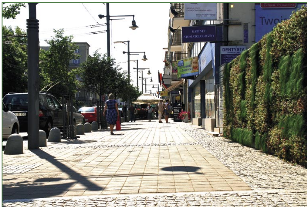
Fot. 12. Zewnętrzna żywa ściana w systemie koszy wypełnionych specjalistycznym substratem glebowym [autor: W. Harbacewicz].
