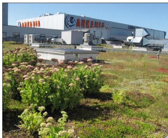
Centrum handlowe ARKADIA – największy dach zielony w Polsce – ok. 30 000 m 2 , wykonany w systemie SOPRANATURE
